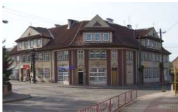
Ryc. 14. Żytkiejmy, kamienica narożna przy głównym skrzyżowaniu (Arch. biblioteki)
