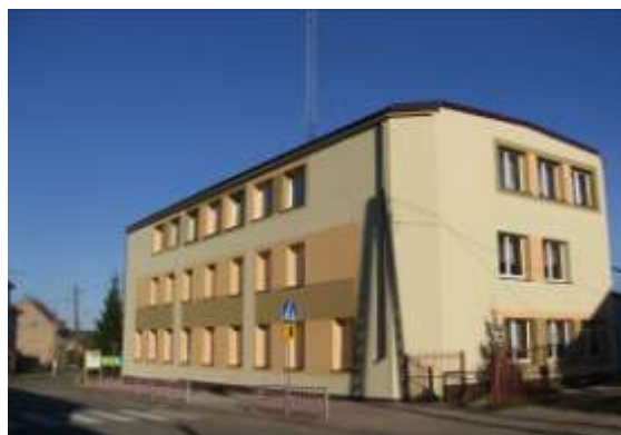
Ryc. 39. Szkoła Podstawowa i Gimnazjum w Żytkiejmach podczas remontu (fot. T. Rydzewska)
