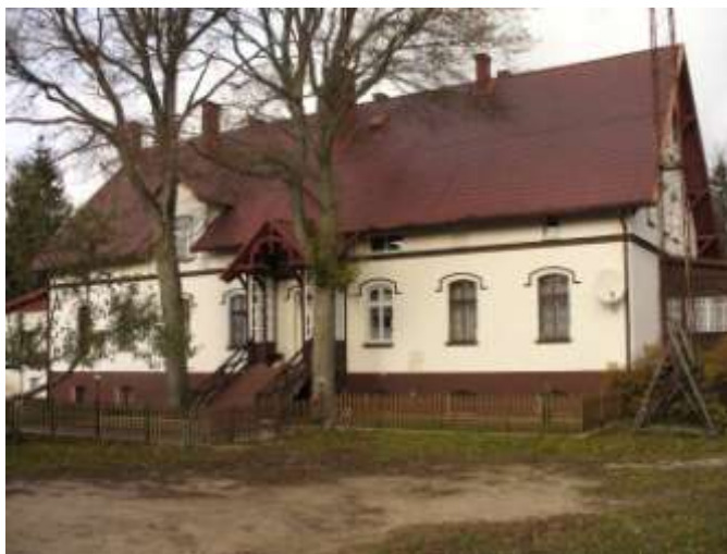
Ryc. 4. Żytkiejmy, budynek byłego nadleśnictwa.
