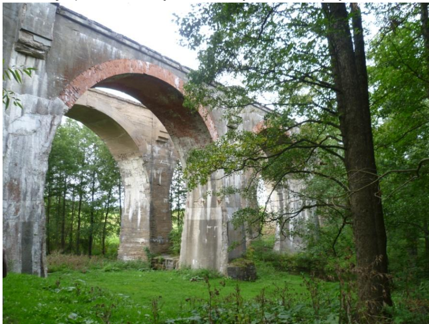
Kiepojcie – mosty kolejowe
