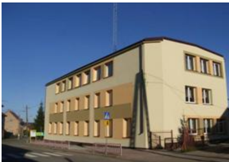
Żytkiejmy – budynek szkoły podstawowej
