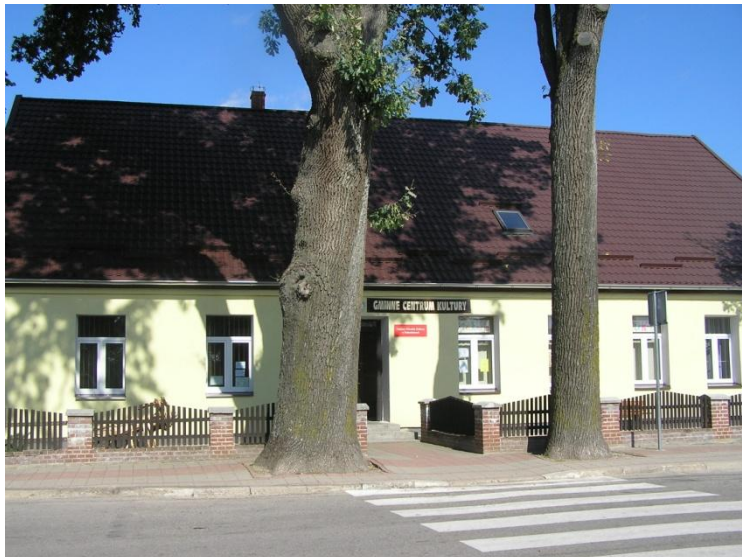
Dubeninki – budynek Gminnego Centrum Kultury
