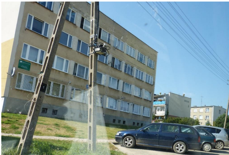
Fot. 2 Główny budynek terenu planu
