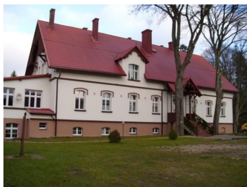
Ryc. 3. Żytkiejmy, budynek byłego nadleśnictwa. (Fot. Arch. biblioteki)
