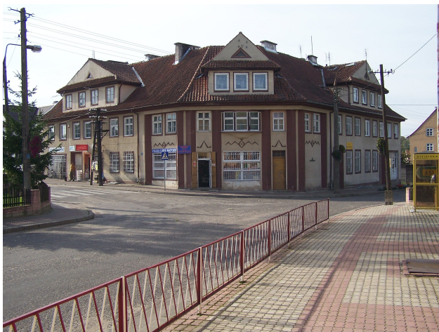
Ryc. 19 Centralne skrzyżowanie w Żytkiejmach
