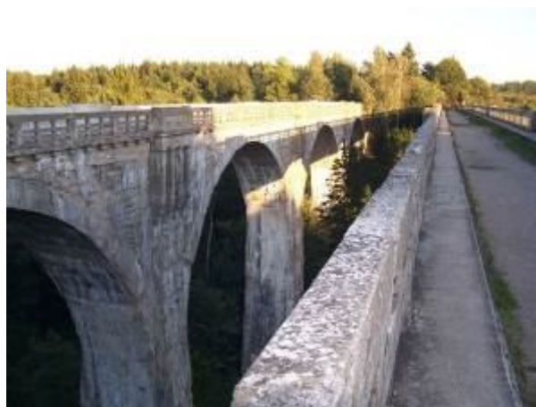
Ryc. 9 Stańczyki, wiadukt kolejowy. Fragment infrastruktury kolejowej w obrębie Puszczy Rominckiej.
