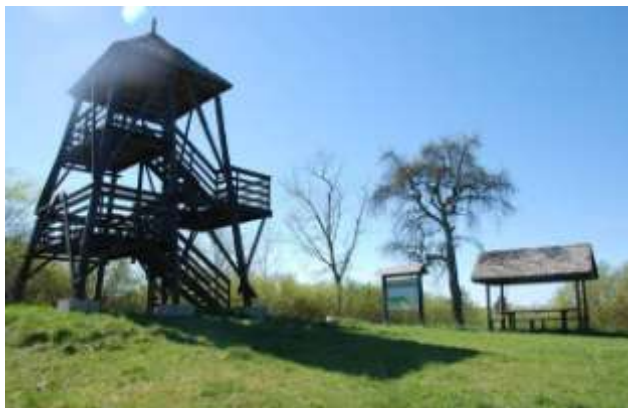
Ryc. 46 Wieża widokowa i wiata turystyczna na ścieżce edukacyjnej „Na skraju puszczy”
