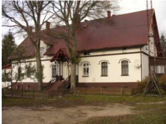
Ryc. 4. Żytkiejmy, budynek byłego nadleśnictwa.
