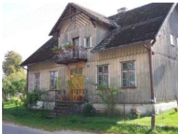
Ryc 3. Żytkiejmy, drewniany budynek mieszkalny.
